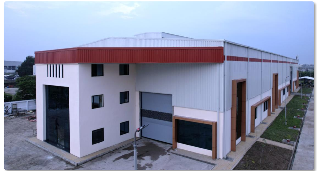
Actual Plant Photograph
